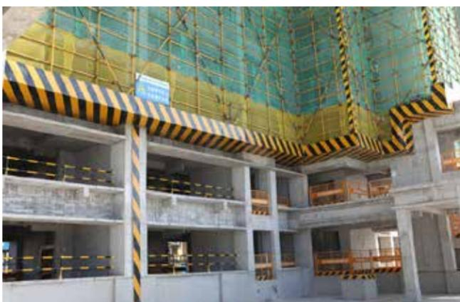
悬挑脚手架工字钢硬质封闭
